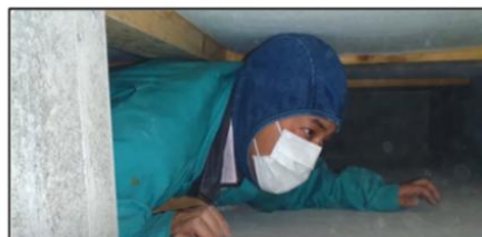
定期点検(床下の点検)
