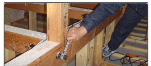
定期点検(天井裏の点検)
